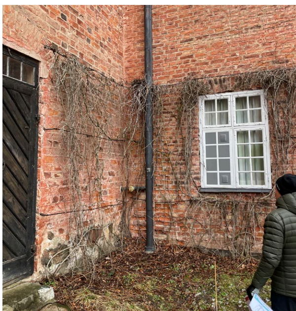
På Gripsholms Slott har man kompletterat med en utvärdig stigarledning som är gömd bakom stuprör. På våningsplanen finns uttag dolt placerade. Bilden till höger visar ett uttag gömt under en bänk, information om detta finns i insatsplanen och är inte skyltat på plats.
