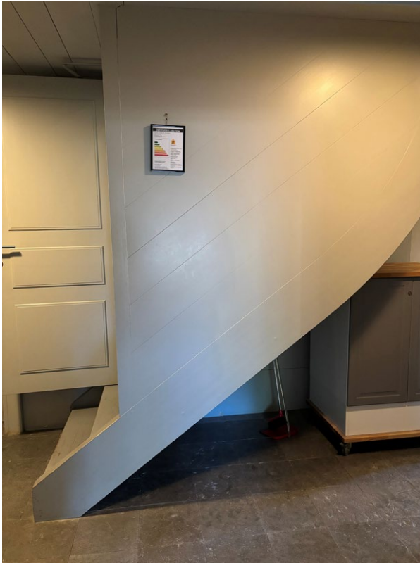
Förstärkning av vindstrappa på Biskops Arnö.
