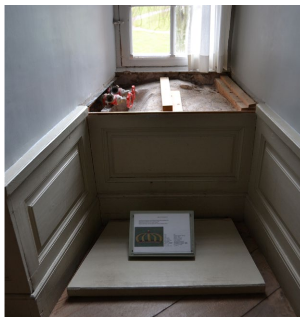
På Gripsholms Slott har man kompletterat med en utvärdig stigarledning som är gömd bakom stuprör. På våningsplanen finns uttag dolt placerade. Bilden till höger visar ett uttag gömt under en bänk, information om detta finns i insatsplanen och är inte skyltat på plats.
