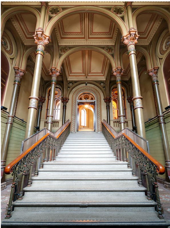
När Gamla riksarkivet uppfördes 1891 var brandsäkerheten viktig och byggnaden fick en obrännbar järnstomme. Den höga brandbelastningen i arkiven skulle dock ha lett till kollaps efter kort tid eftersom järnstommen snabbt tappat sin hållfasthet vid brand. Vid ombyggnaden 2008–2011 förbättrades därför brandmotståndet genom att pelare och balkar renskrapades och brandskyddsmålades. Med stöd av analytisk dimensionering kunde de dekorativa delarna, som hade tjockare gjutgods, behållas intakta.
