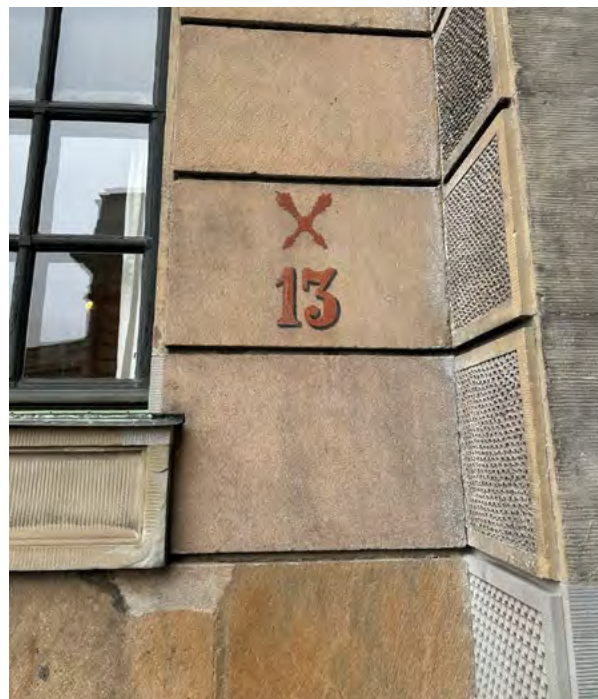
Branddörrar på Stockholms slott från slutet på 1800-talet försågs med en symbol i form av två korslagda facklor som visar funktionen som branddörr samt nummer på vilken brandmur de sitter. Denna numrering finns även på fasaden på inre borggården.
