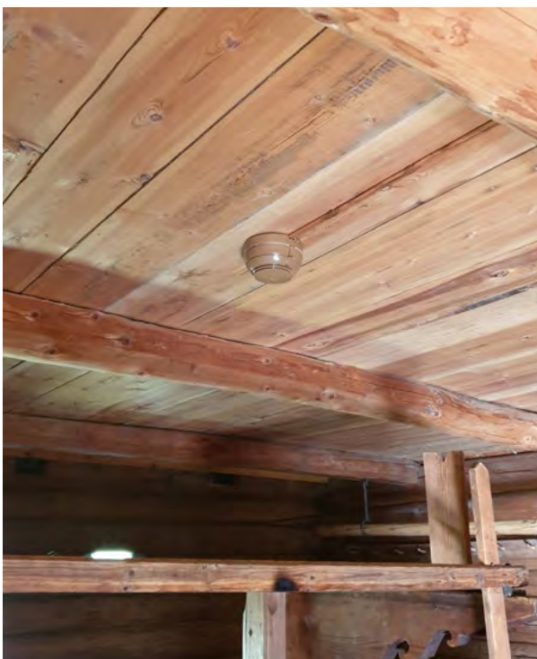
Inmålad rökdetektor från en kulthistorik byggnad i Norge.
