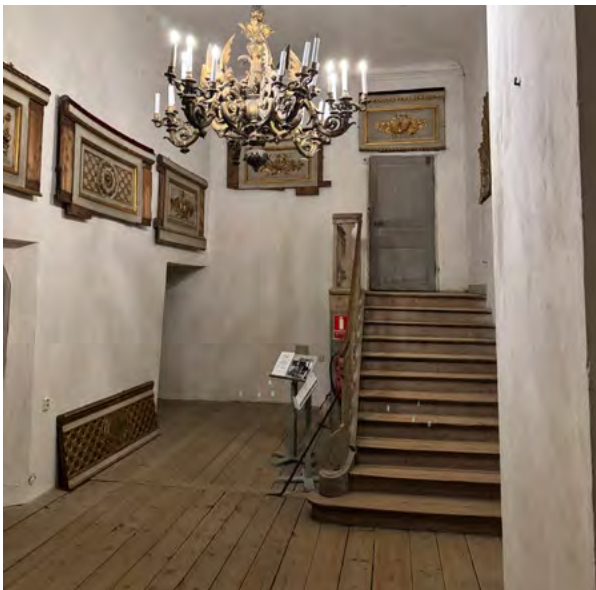
Brandsläckare på Drottningholms Slottsteater är placerade diskret men lättillgängligt för att minimera den visuella påverkan på rummet.
