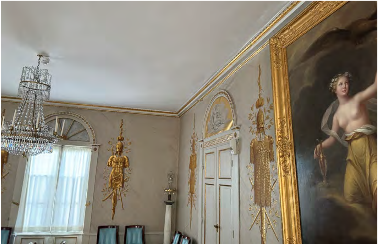
På Rosendals slott används trådlösa rökdetektorer i känsliga utrymmen. På bilden syns en trådlös rökdetektor placerad i samma upphängning som ljuskronan.
