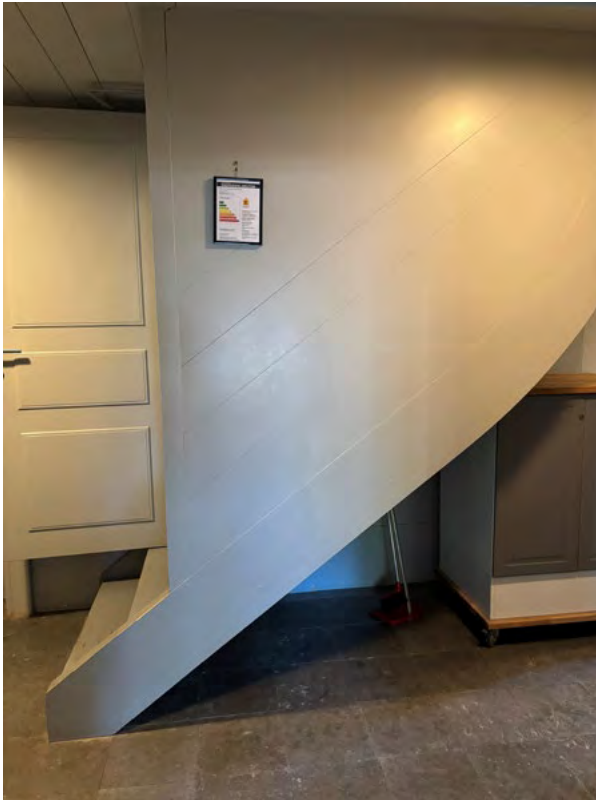
Förstärkning av vindstrappa på Biskops Arnö.
