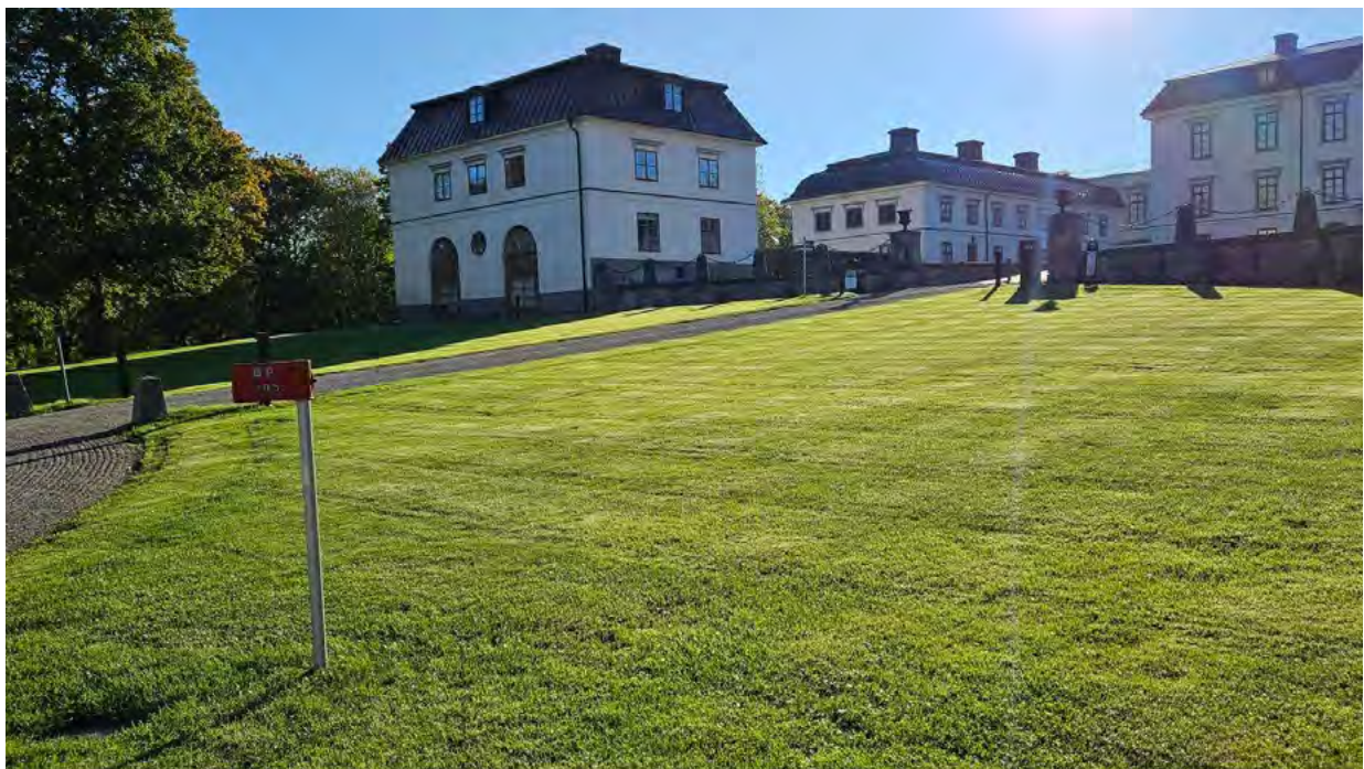
Vid Rosersbergs slott har man valt en särskild anpassning för brandpostskylten genom att placera den lågt intill grusytan. Detta har gjorts för att minimera dess visuella påverkan på den historiska slottsmiljön. Vanligtvis monteras dessa skyltar på en höjd av 2,2 meter över marken, men i detta fall har man alltså frångått standardhöjden för att minimera den visuella påverkan på slottsvyn.
