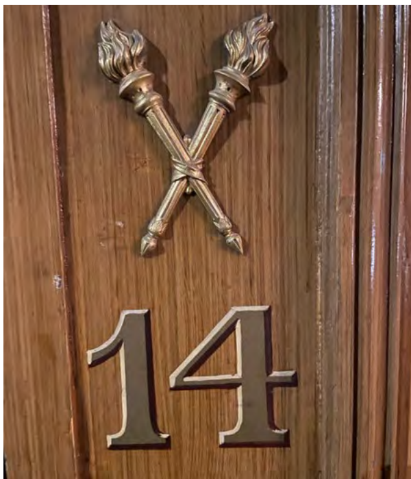
Branddörrar på Stockholms slott från slutet på 1800-talet försågs med en symbol i form av två korslagda facklor som visar funktionen som branddörr samt nummer på vilken brandmur de sitter. Denna numrering finns även på fasaden på inre borggården.
