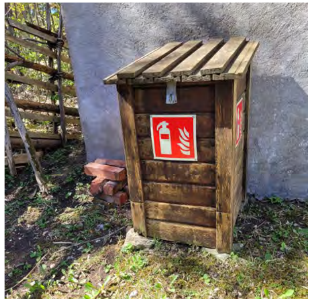
Utvändig släckare på Norrlanda Forngård, Gotland. Släckaren är placerad i en trälåda som smälter in i miljö samt skyddar släckaren.
