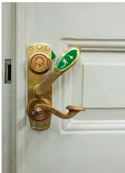
Nödutrymningsbeslag i kombination med ett posthornstrycke på Wrangelska palatset i Stockholm.
