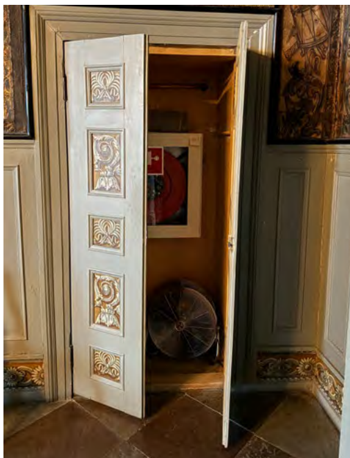
Inomhusbrandpost dold i nisch på Drottningholms Slott.
