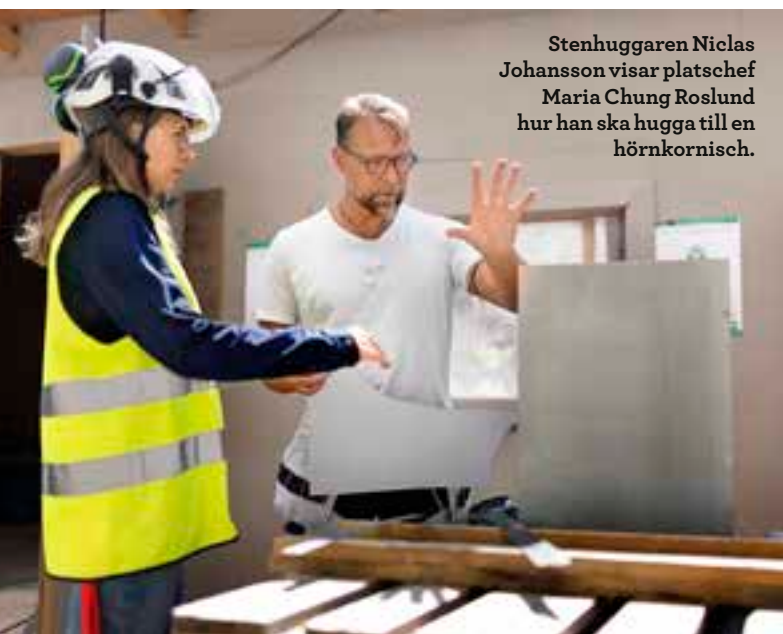
Kopparplåten på taket byts ut och skadat trä ersätts.
