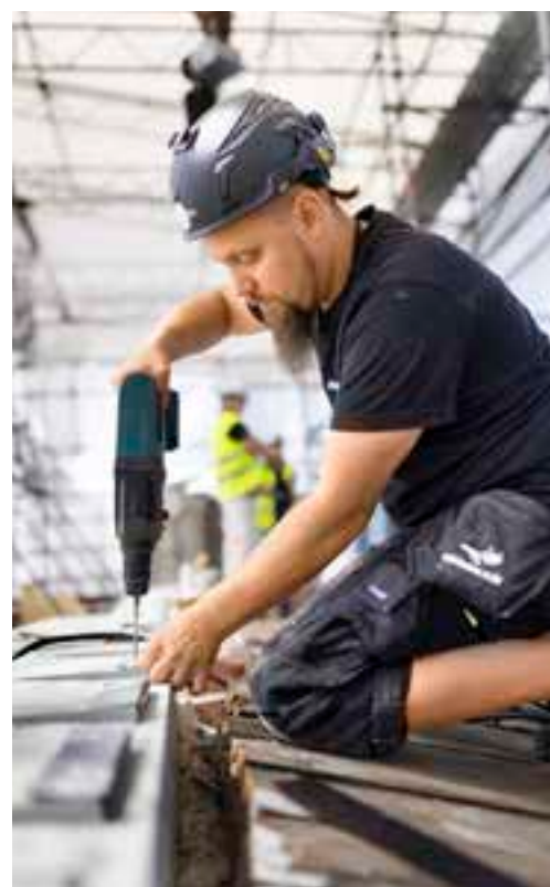
Plåtslagaren Patrik Ekström monterar fästbläck för att plåten ska kunna avleda vatten från balustraden.
