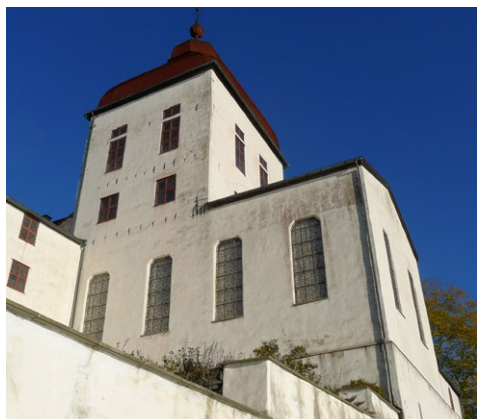
Slottskyrkan på Läckö slott restaureras med hjälp av det utökade bidragsanslaget – puts av fasad, tätning av skiffertak och renovering av takspiror. Foto: SFV/Olle Nyland
