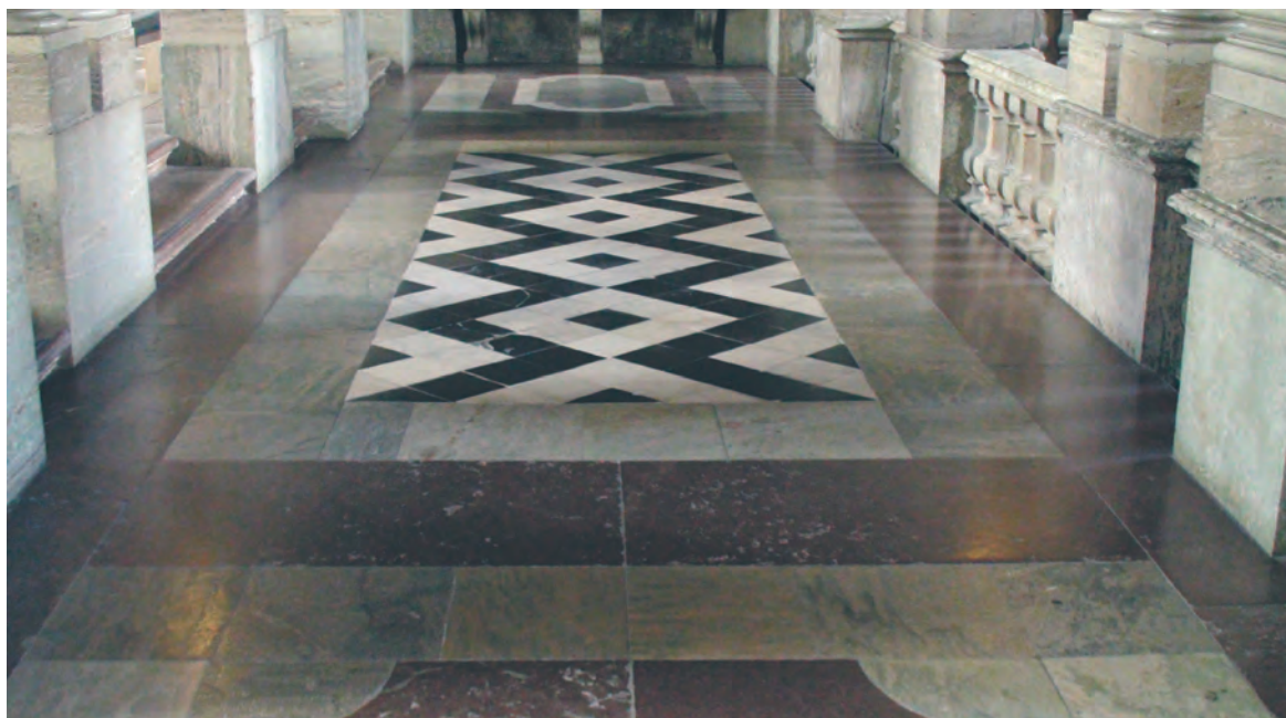
Marmor- och kalkstensgolv på Stockholms slott. För mycket vatten under rengöring kan leda till att fogar luckras upp och stenplattor lossnar och spricker. Följ den gyllene regeln om att använda minimalt med vatten.
