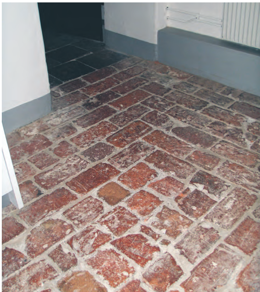
Tegelgolv med lösa fogar i Södra Bankohuset.
