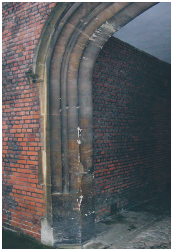
Bilden visar ett engelskt stenvall med anor från 1500-talet. Skadorna uppstod när man ville köra in en last som var för stor. FOTO: LISA NILSEN.
