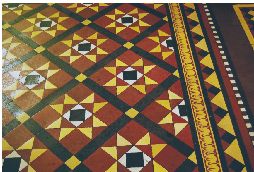
Uppsala universitetshus står med vackra golv, som här i trapphallens mönsterlagda tiles.
