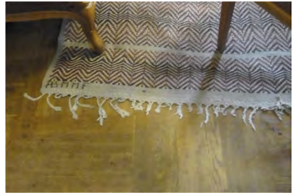
Här har slitaget gått för långt. Skadorna borde ha åtgärdats för länge sedan. Kontakta SFV:s inredningsarkitekter i ett tidigt förslitningskede. Foto: Lisa Nilsen
