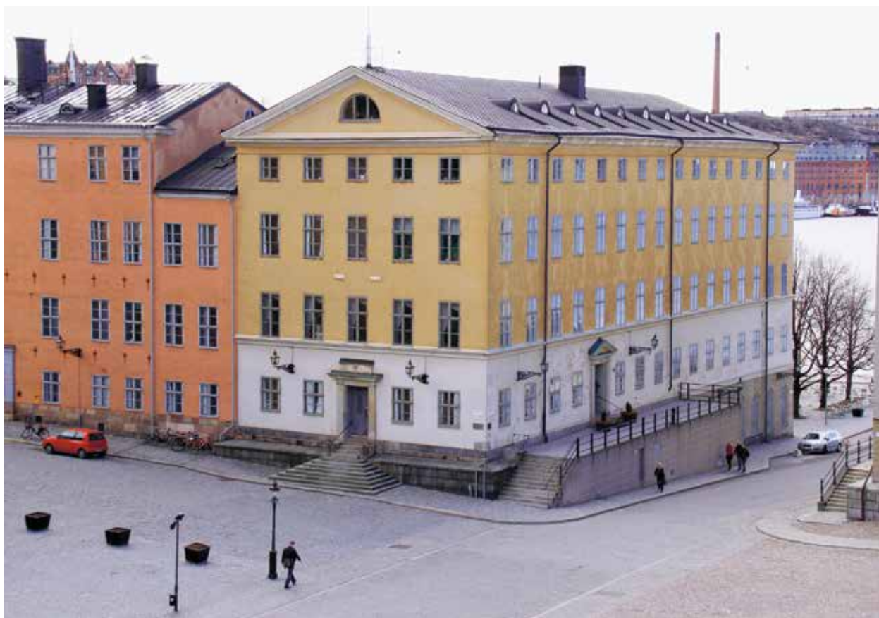
Fasadernas färgsättning från 1974 med vitt på övre sockelvåningen. Foto: Alexandru Baboș 2006.
