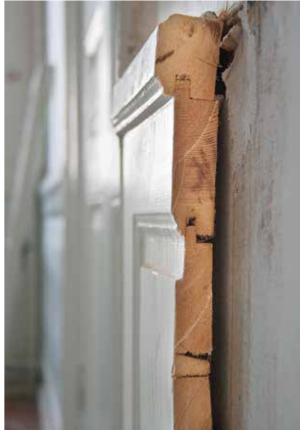
Skärnitt genom ursprunglig bröstpanel vid öppning av ny dörr mellan stora rum. Foto: Alexandru Baboș, 2010.
