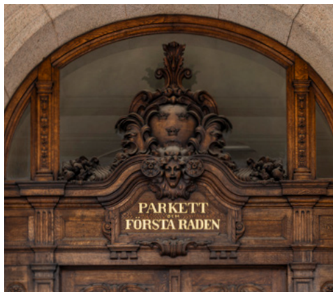
SFV hemställer hos regeringen om att, inom en ram på 3,25 miljarder kronor, genomföra renovering av operabyggnaden i Stockholm. Foto: Melker Dahlstrand och Ida Borg
