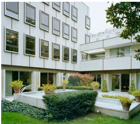
Sveriges ambassad i Paris, som även innehåller residens och Sveriges OECD-kontor, renoveras under året. Projektet, som till stora delar är ett säkerhetsprojekt, handlar bland annat om att skapa separata entréer för besökare och ambassadpersonal. Foto: Åke E:son Lindman
